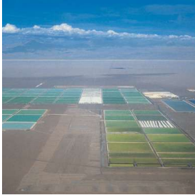
□ Pozas de evaporación solar en el Salar de Atacama.
