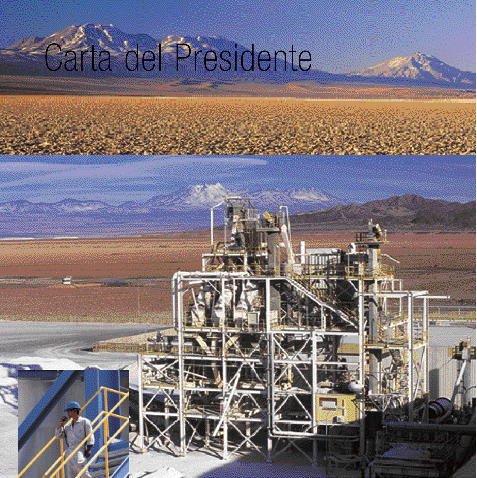
Planta de secado-compactado de sulfato de potasio.
