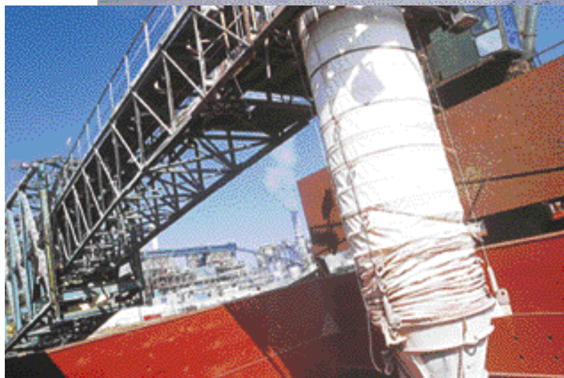
Chute telescópico para descarga de productos en el Puerto de Tocopilla.
