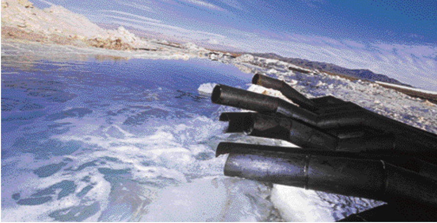
Canales recolectores de salmuera.
